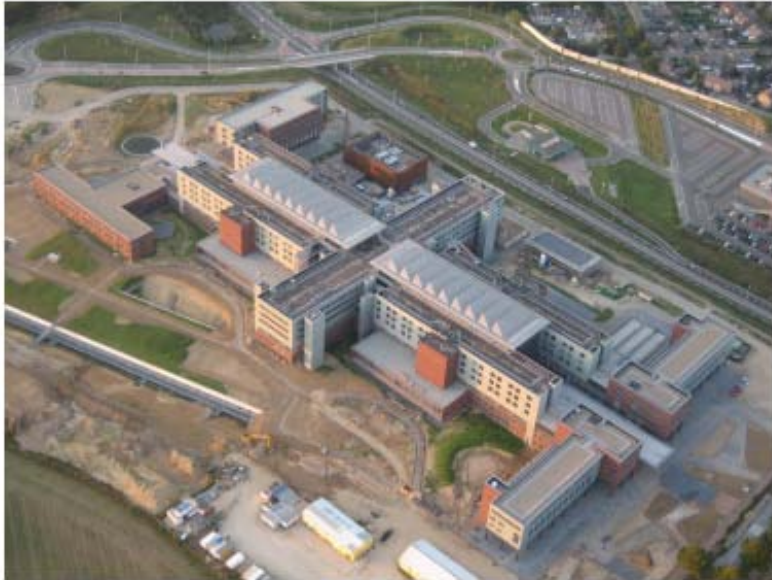
Kuva 5. Maaslandin maakunnan keskussairaala, Sittard. Edessä on liikekeskus, risti-osassa päivystys, leikkaus ja tehot sekä muut sairaalafunktiot. Päässä ovat psykiatrian ja kuntoutuksen yksiköt omina sairaaloinaan
